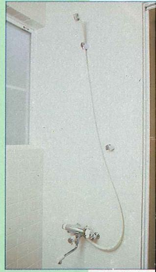
シャワーしている際に、急に湯温が下がったり上がったりは、とても不快。そんな気分を味わわなくてよい、湯温を一定させることが出来るサーモスタット付きシャワー。電化された給湯システムだから、栓をひねれば常に一定温度が保たれるので、さらに湯温は完全安定。
